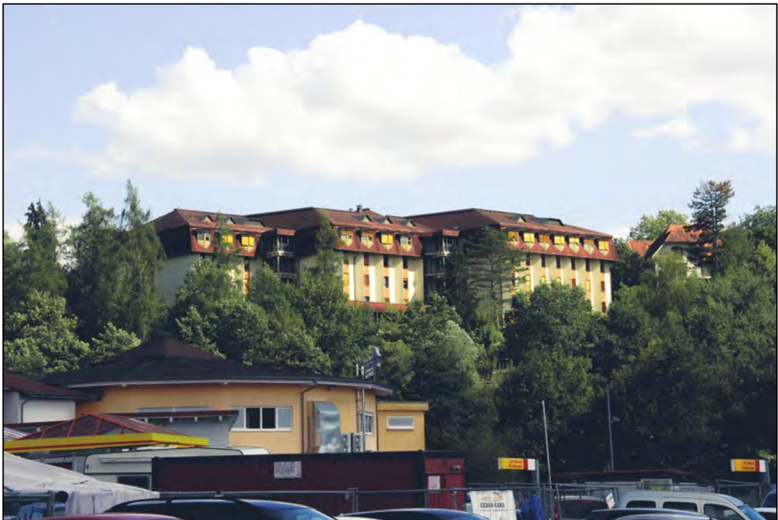
Abbildung 6: Blick auf das deutlich in Erscheinung tretende Haus Entegast und die benachbarte Villa. Quelle: Stadtbau Lörrach. Juli 2022.
